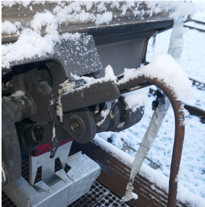
Abbildung 7: Am Chassis des LKWs angebrachte Erdungszange.
